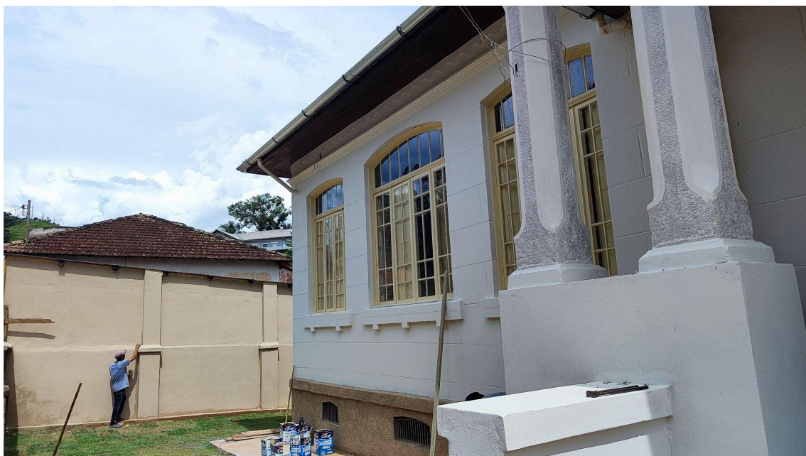
Forros em processo de finalização e pintura interna e externa em andamento Autoria: Francielle Ferreira Data: 27/01/2025
