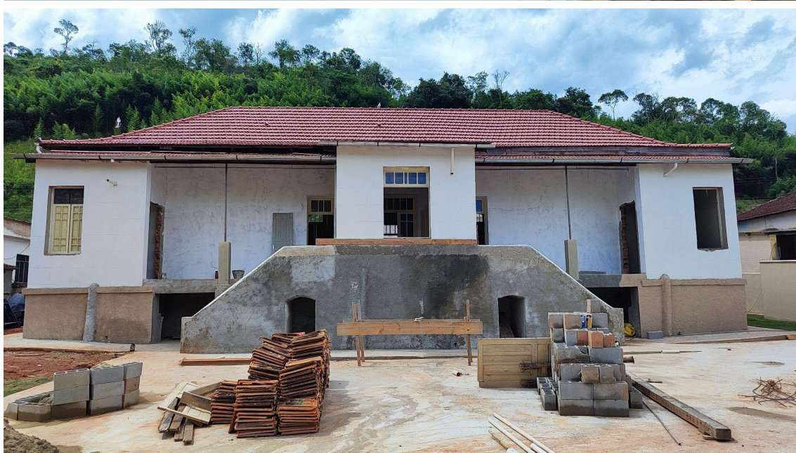
Serviços de reforma do telhado executados Autoria: Francielle Ferreira Data: 27/01/2025
