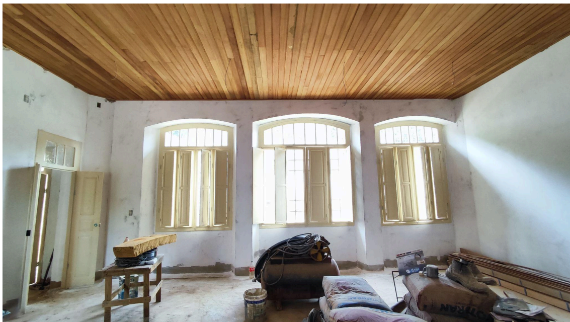
Muro e contrapiso executados Autoria: Francielle Ferreira Data: 27/01/2025
