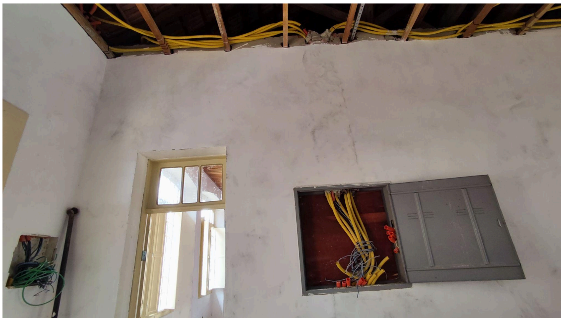
Infraestrutura elétrica e telefônica executada. Quadros elétricos e de telefonia em processo de montagem Autoria: Francielle Ferreira Data: 27/01/2025
